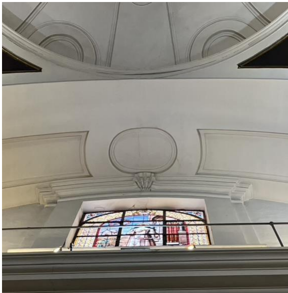
IGLESIA PARED LATERAL DERCHA INTERIOR DESDE PISO A TECHO
